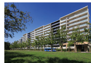
【ルネ稲毛海岸グランマックス】 (千葉県千葉市/2020年竣工)
