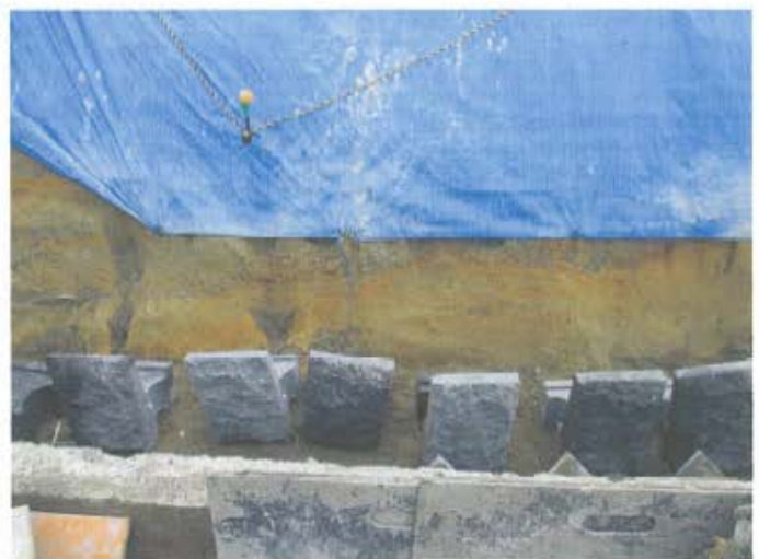
第5図 道路法面に見られる地層（右が真西）
