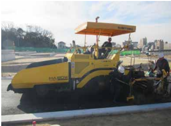
アスファルトフィニッシャー(W=2.4 ~ 6.0m)
