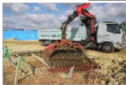
スクラップ仮置 積込み状況
