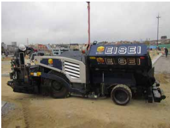
アスファルトフィニッシャー(W=2.4 ~ 4.5m)
